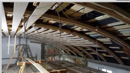
November 2023 Die Spanten für das neue Holzgewölbe müssen vor Anbringung der Latten verstärkt werden
