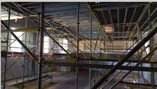
17.07. - 02.08.2023 Gerüstaufbau für die Entfernung des Holzgewölbes und der mit Asbest belasteten Mineralwolle
