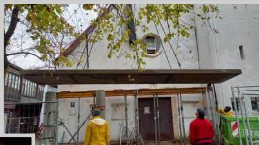
November 2023 Die Spanten für das neue Holzgewölbe müssen vor Anbringung der Latten verstärkt werden
